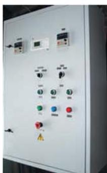
на основе микроконтроллера MITSUBISHI (Япония) и с использованием пускорегулирующей аппаратуры SCHNEIDER (Франция), позволяет осуществлять регулирование процесса горения и подачи топлива в автоматическом и ручном режимах. Производит измерение и регулирование по основным параметрам (температура теплоносителя, температура топки и отходящих газов), слежение за
